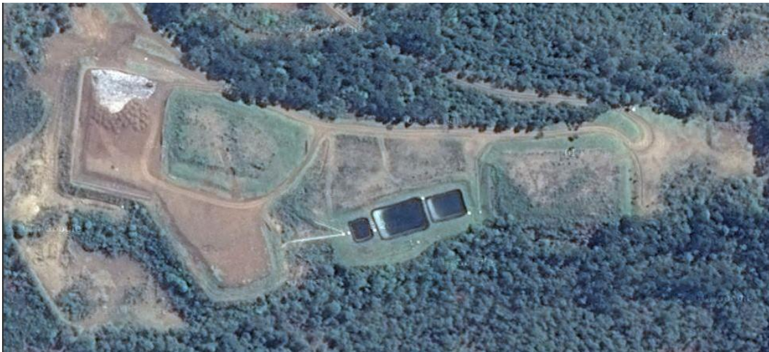
Figura 05 – Área do Aterro Sanitário de Porto União
