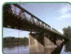
Ponte Machado da Costa (Ponte de Ferro)
