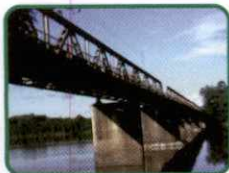
Ponte Machado da Costa (Ponte de Ferro)
