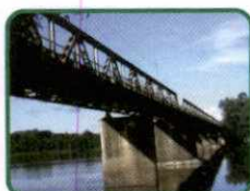
Ponte Machado da Costa (Ponte de Ferro)
