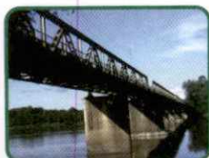
Ponte Machado da Costa (Ponte de Ferro)
