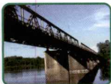
Ponte Machado da Costa (Ponte de Ferro)
