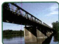
Ponte Machado da Costa (Ponte de Ferro)
