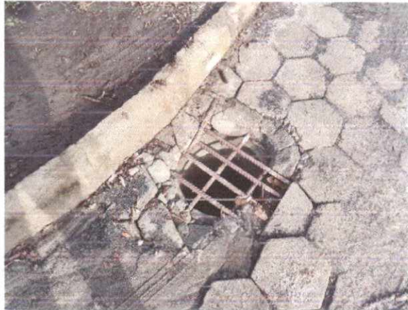
Foto 03 - Bueiro com diâmetro de 40 cm
