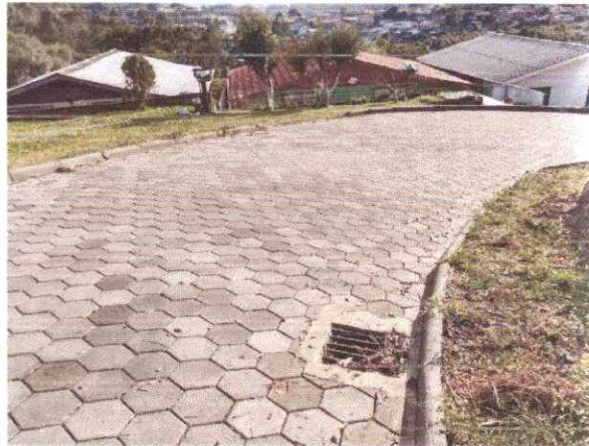
Foto 05 - Bueiro com diâmetro de 60 cm
