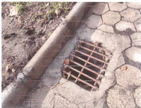
Foto 04 - Bueiro com diâmetro de 60 cm
