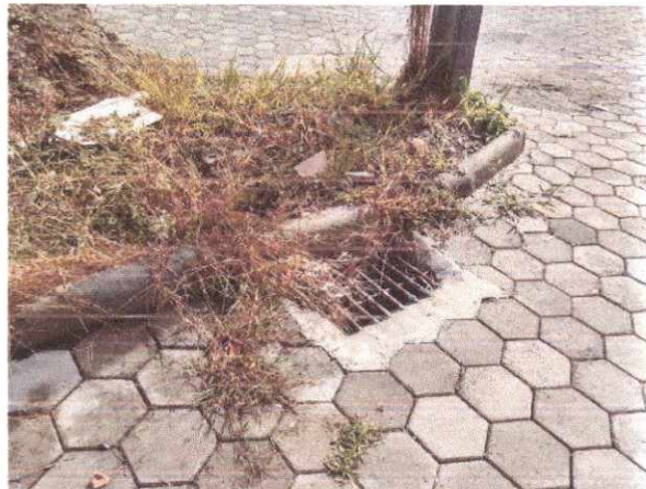
Foto 06 - Bueiro com diâmetro de 60 cm
