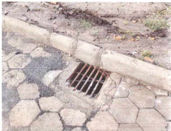
Foto 01 - Bueiro com diâmetro de 40 cm
