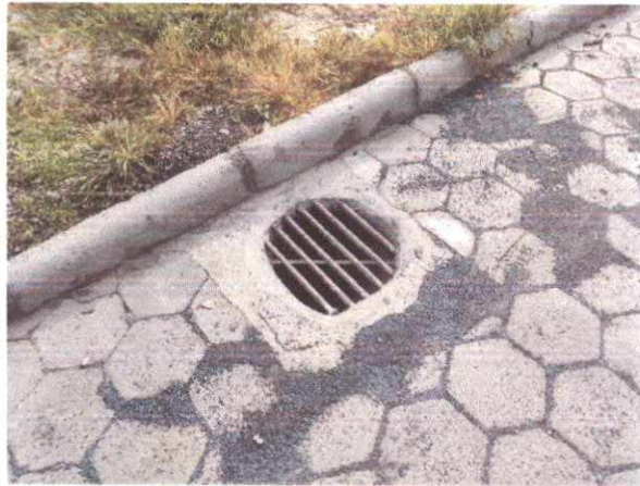
Foto 02 - Bueiro com diâmetro de 40 cm
